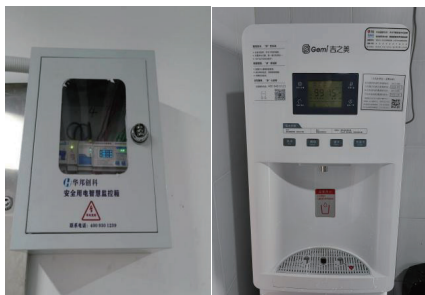
图 2-49 安装安全用电、智能净水设备
